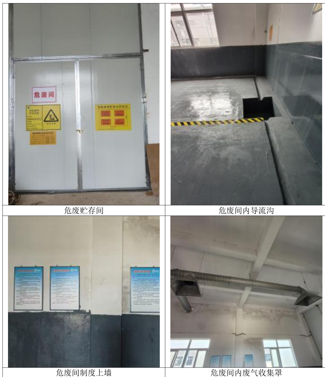
图 4.4-1 危险废物贮存设施现场情况
