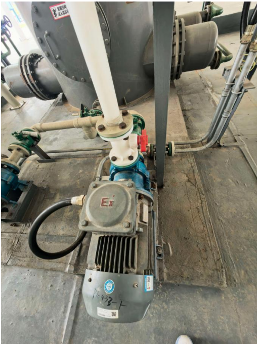
图 4.3-1 隔声减震设备底座
